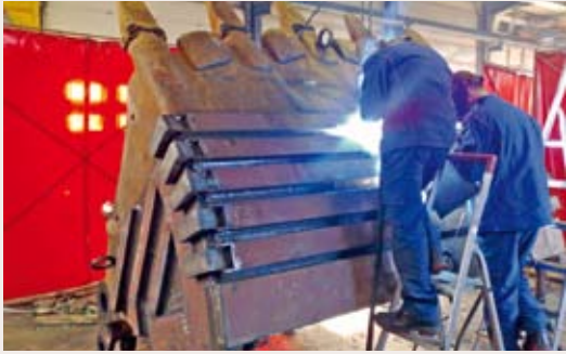
„AUS ALT MACH NEU“ lautete der Auftrag. Das hieß abtrennen, zuschneiden, anpassen, einschweißen und montieren.
