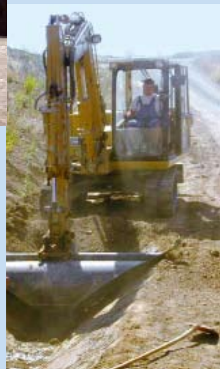
Trapezlöffel schwenkbar
